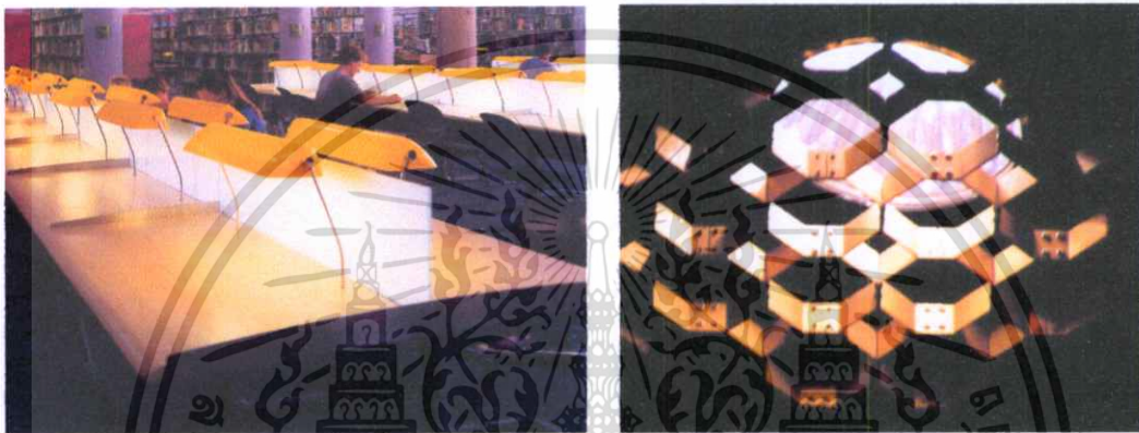
รูปที่ 2.24 แสดงการติดตั้งโคมไฟเพิ่มเพื่อลดความต่างของแสง และ การใช้วัสดุเพื่อช่วยลดแสงบาดตา
