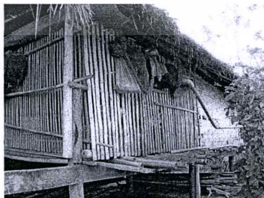
รูปที่ 4.184 ผนังส่วนครัวเป็นไม้ไผ่ผ่าซีก
