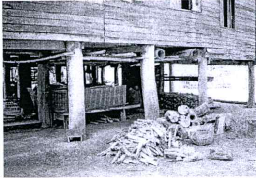
รูปที่ 4.64 ใต้ถุนเรือนมีแคร่ที่นั่งเล่น (จิรศักดิ์ แต่งเจนกิจ. 2537 : 43-45)
