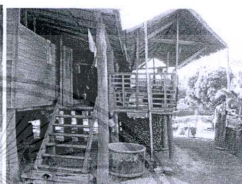
รูปที่ 6.8 บันได และเสาหลังหมา
