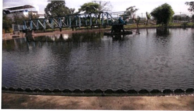
รูปที่ 3.3 ถังตกตะกอนขั้นสุดท้าย
