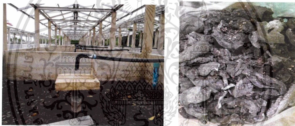
รูปที่ 2.2 ลานตากตะกอน(ก) สลัดจ์ในลานตากตะกอน (ข) ลักษณะตะกอนที่ได้จากลานตากตะกอน
