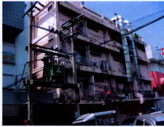
ภาพที่ 4.33 การติดตั้งหม้อแปลงไฟฟ้าอาคาร
