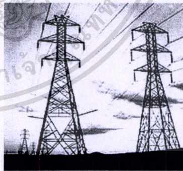
รูปที่ 4.1 ลักษณะสายส่งไฟฟ้าแรงสูง 500kV ชนิดวงจรเดี่ยวและวงจรคู่ของการไฟฟ้าฝ่ายผลิต
