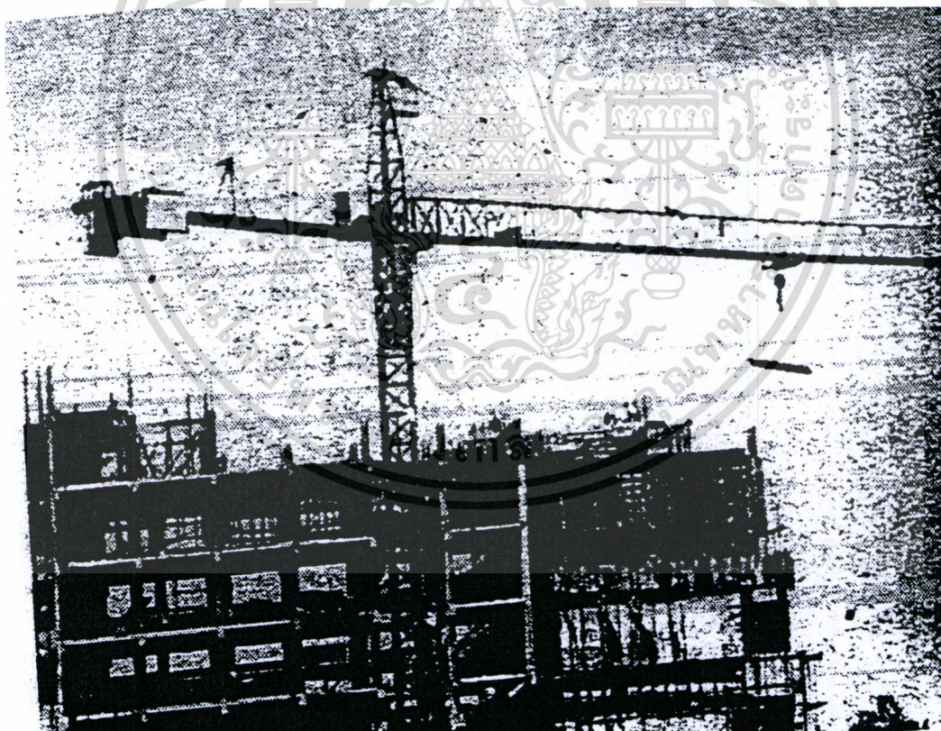
รูปที่ 2.3 ทาวเวอร์เครนแบบเคลื่อนที่ทางแนวดิ่ง
