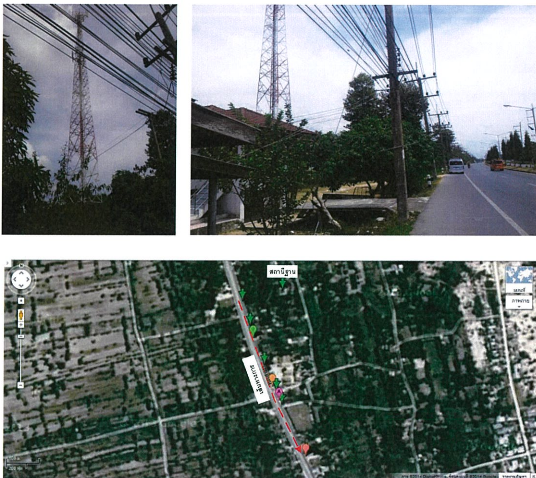
รูปที่ 3.8 ภาพถ่ายสถานที่จริงในการทดสอบระดับความแรงการแผ่คลื่นแม่เหล็กไฟฟ้าจากสถานีฐานส่งสัญญาณโทรศัพท์เคลื่อนที่ ตำบลสนามชัย อำเภอสทิงพระ จังหวัดสงขลา [12]
