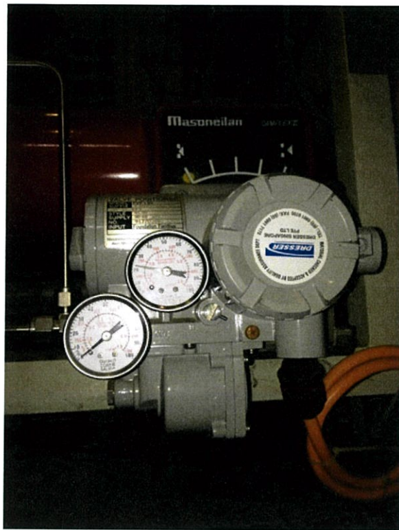
รูปที่ 4.5 Valve Positioner ของ Dresser
