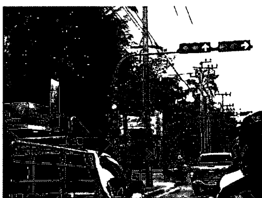
3. ป้ายแนะนำเส้นทางติดตั้งต่ำกว่าข้อกำหนด (ถนนนวมินทร์)
