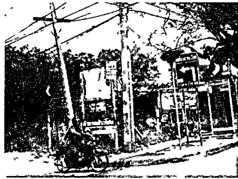
4. ป้ายแนะนำเส้นทางและป้ายเส้นทางลัด ที่ติดตั้งไม่เป็นระเบียบ (ถนนลาดพร้าว 101)
