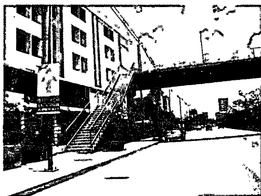
6. สภาพสะพานลอยคนข้าม
