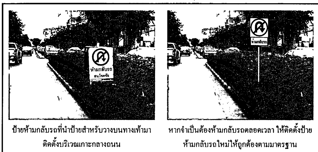
รูปที่ 5.27 แสดงตัวอย่างการปรับปรุงป้ายห้ามกลับรถบนเกาะกลางถนน
