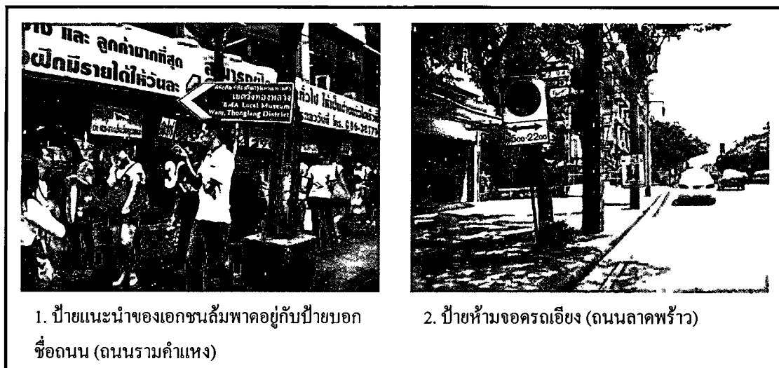
รูปที่ 4.24 แสดงป้ายจราจรที่มีปัญหาเกี่ยวกับโครงสร้างรองรับป้ายจราจร
