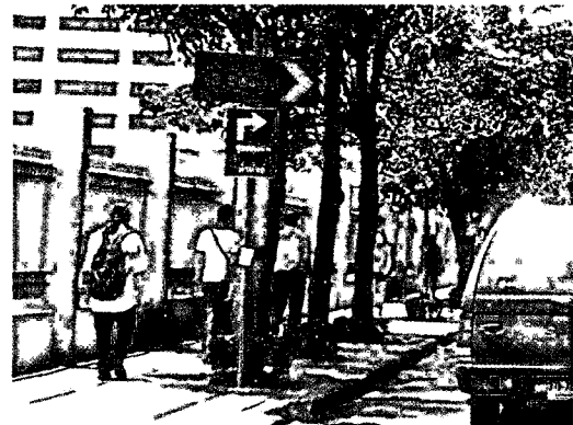
ป้ายชี้ทางและป้ายบอกจุดหมายปลายทางที่ขนาดแตกต่างกัน ติดตั้งบนเสาเดียวกัน
