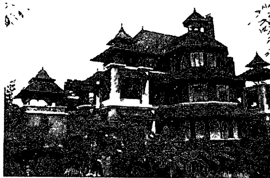
ภาพที่ 4.94 แสดงลักษณะอาคาร Regent Residence
