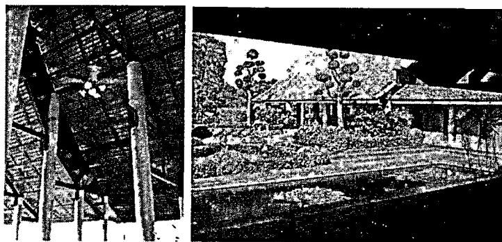
ภาพที่ 4.115 งานระบบปรับอากาศที่ใช้ในสนามบินจะเป็นพัดลมปรับอากาศและอากาศจากธรรมชาติมีการบ่อน้ำโดยรอบเพื่อให้มีลมความเย็นพัดเข้ามาในตัวอาคาร
