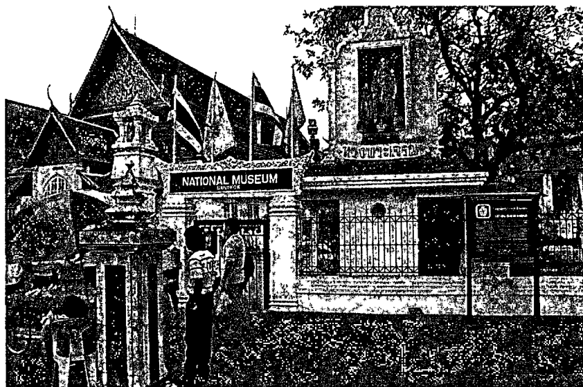
รูปที่ 2.7 พิพิธภัณฑ์สถานแห่งชาติพระนคร กรุงเทพมหานคร
