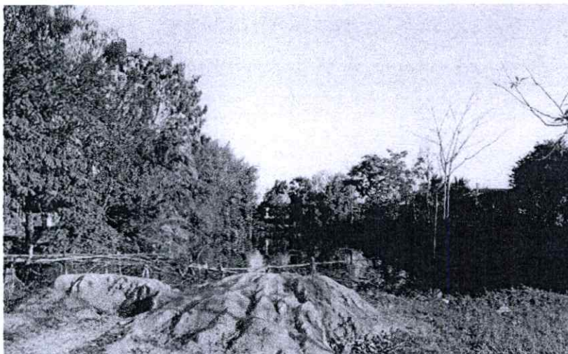
รูปที่ 3.26 แสดงลำน้ำสาธารณะสำหรับระบายน้ำและใช้ประโยชน์ต่างๆในหมู่บ้าน
