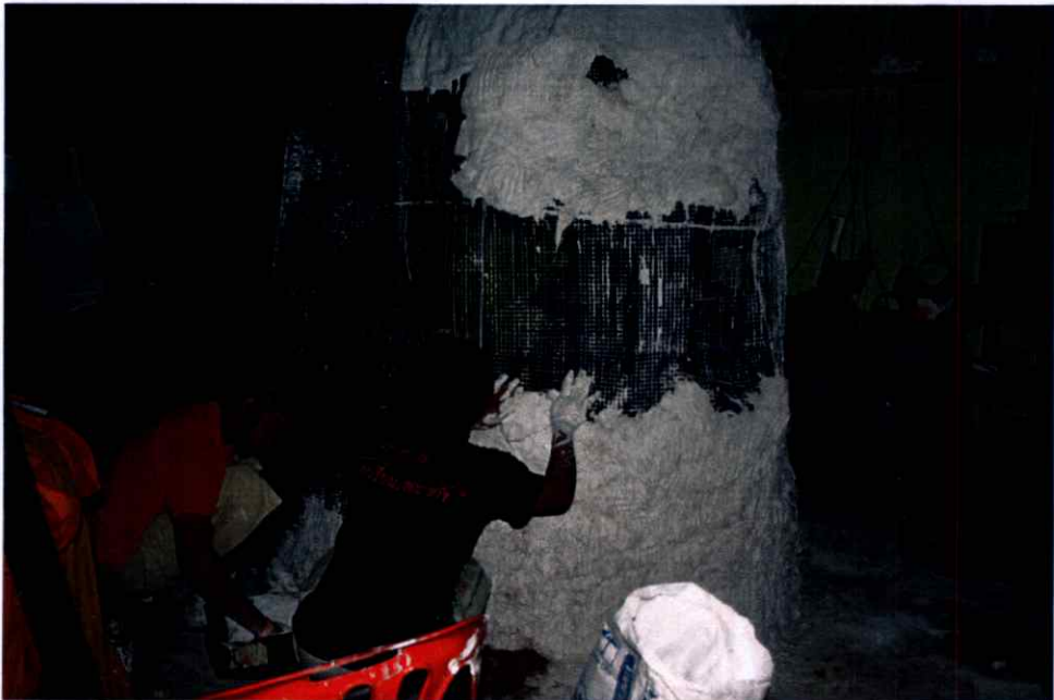
ภาพที่ 3.5 ขั้นตอนการทำโครงสร้าง
