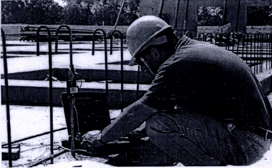
รูปที่ 3.33 แสดงตัวอย่างการวัดระดับการแข็งตัว (Maturity) ด้วยเครื่องมือวัด
