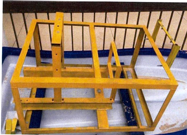
รูปที่ 3.24 ภาพถ่ายโครงสร้างหลักระบบทำน้ำจืดจากน้ำทะเลโดยใช้พลังงานคลื่น (ด้านข้าง)
