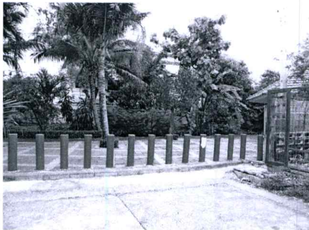
รูปที่ 4.14 แสดงด้านหลังของ โครงการที่จัดเป็นส่วนสาธารณะ
