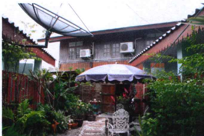
ภาพที่ 3.22 รูปด้านหลังและทางเข้า
