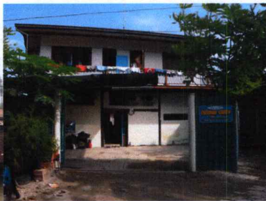
ภาพที่ 3.11 ลักษณะอาคาร ด้านหลัง
