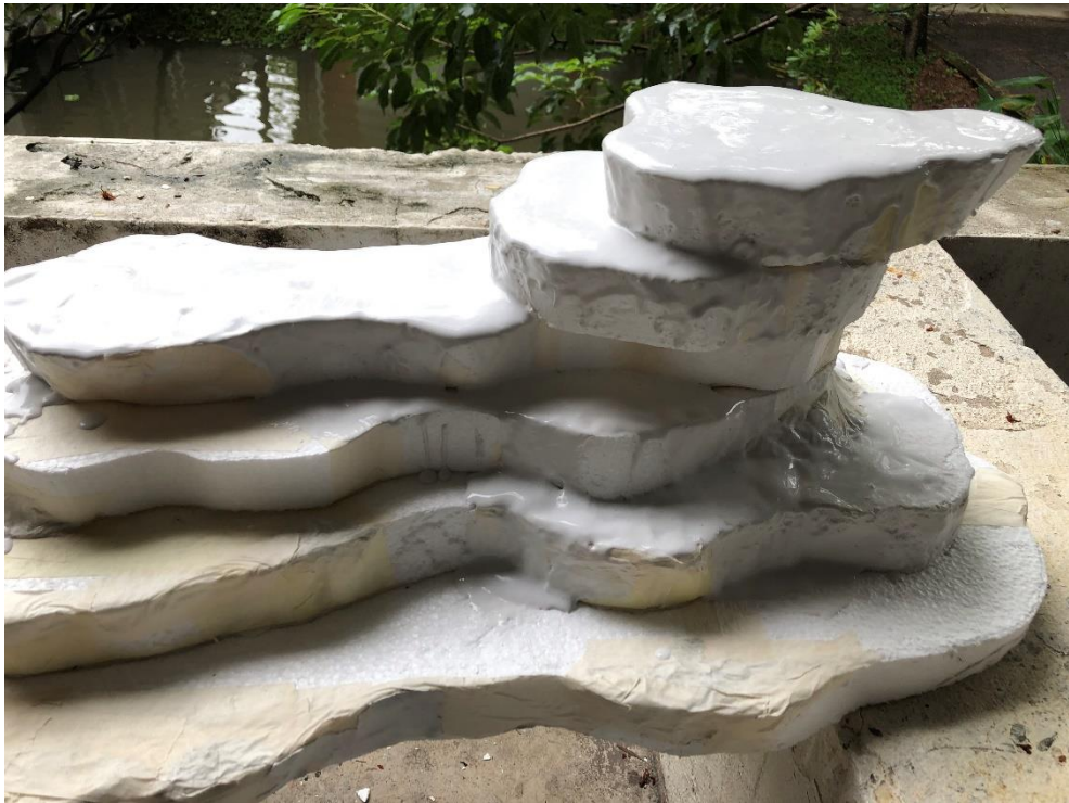
ภาพที่ 3.21 ชั้นตอนที่ 3 เทปูนพลาสติกที่ผสมจนเข้ากันแล้วลงไปยังโฟมที่สร้างเป็นรูปทรงไว้
