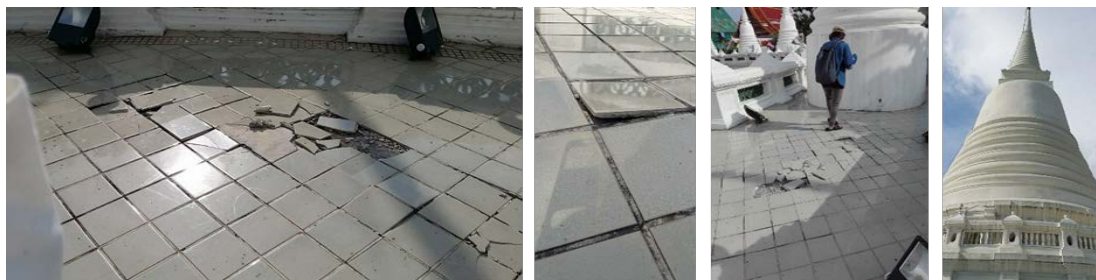
ภาพที่ 2.19 ลักษณะความเสียหายของกระเบื้องพื้นหลังการกระเบื้องคดชั้นที่ 2 หลังการบูรณะ ที่มาของภาพ : ผู้วิจัย
