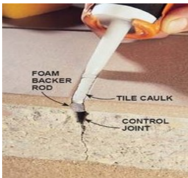
ภาพที่ 5.1 กาวยาแนวชนิดยืดหยุ่นอัดรอยร้าว ที่มา: weberthailand, 2559
