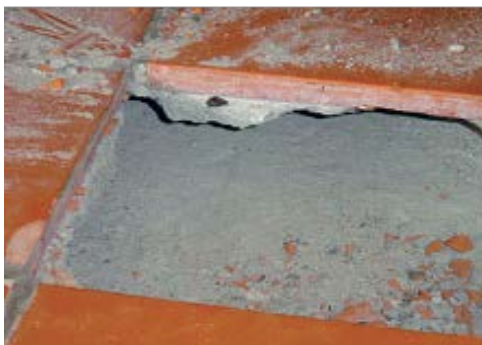
ภาพที่ 2.20 การหลุดล่อนเป็นแผ่นจากวิธีการปูที่ไม่ได้มาตรฐาน
