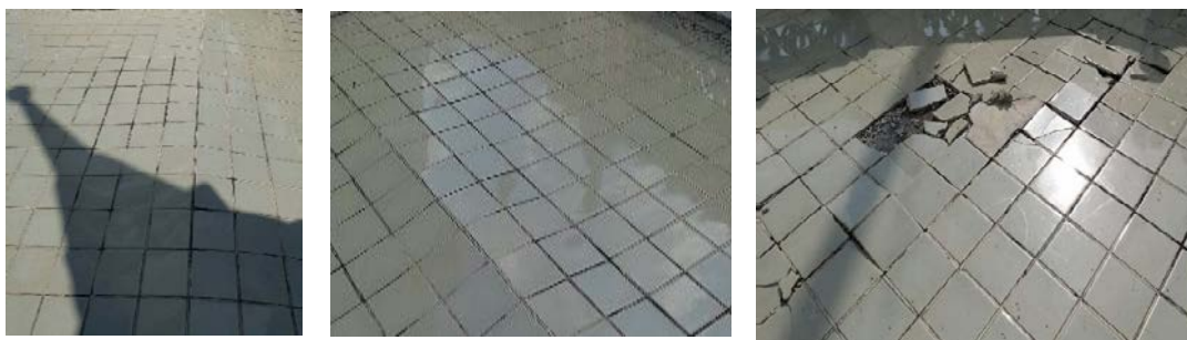
ภาพที่ 4.3 ลักษณะความเสียหาย ระดับที่ 1 ระดับที่ 2 และระดับที่ 3 ที่มา : (ผู้วิจัย, 2559)
