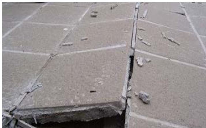
ภาพที่ 2.22 การแตกร้าวของวัสดุ เกิดจากการยืด-หดตัวของวัสดุเนื่องจากอุณหภูมิ ที่มา: บริษัท แชน-โกแบ็ง เวเบอร์ จำกัด. 2559ค
