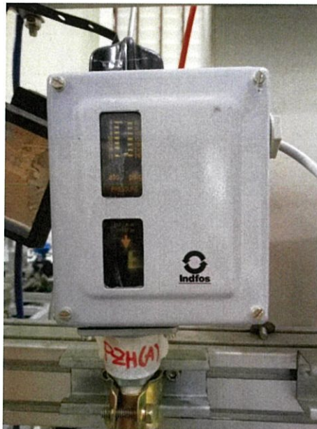
รูปที่ 2.13 Pressure Switch
