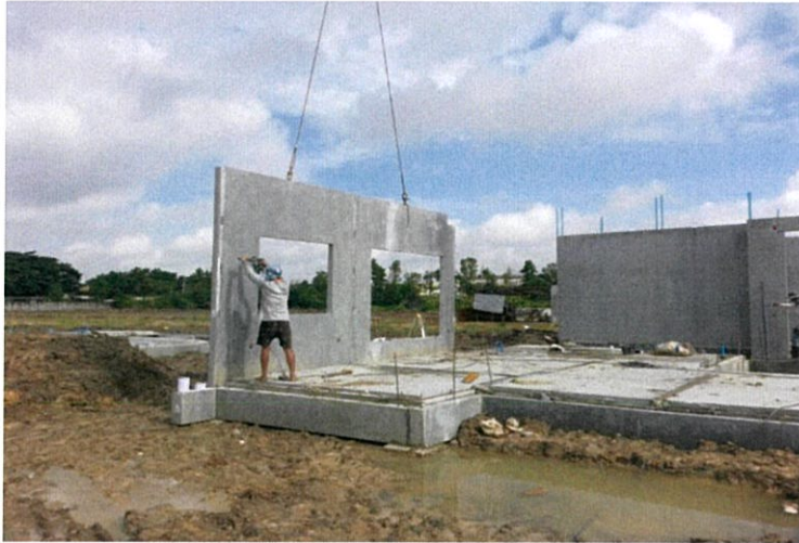
รูปที่ 2.5 การติดตั้งผนังคอนกรีตรับแรง
