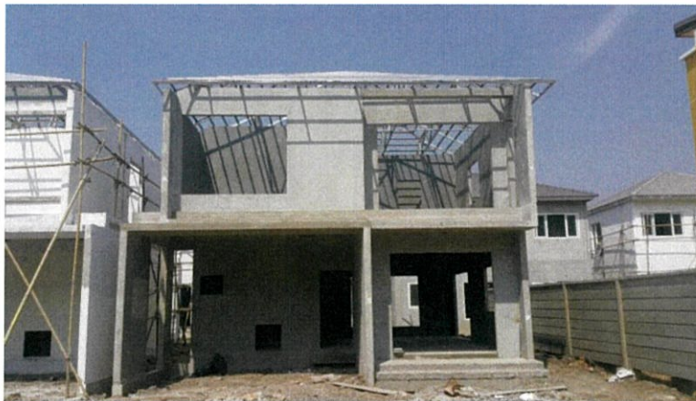
รูปที่ 3.21 การติดตั้งโครงหลังคา
