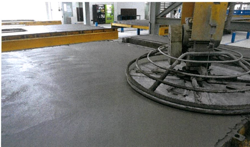
รูปที่ 2.12 การขัดผิวหน้าคอนกรีต
