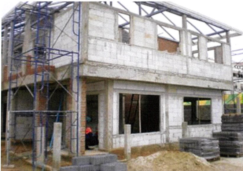
รูปที่ 2.2 การก่อสร้างโดยใช้คอนกรีตเสริมเหล็ก
