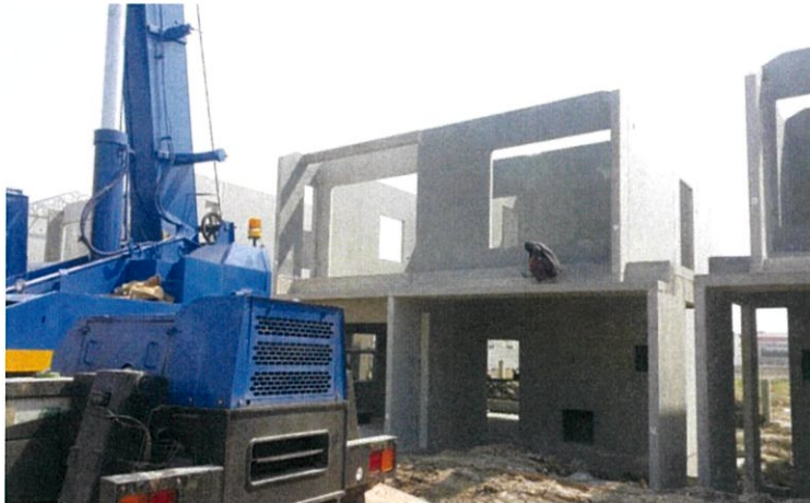
รูปที่ 3.19 การติดตั้งผนังชั้น 2
