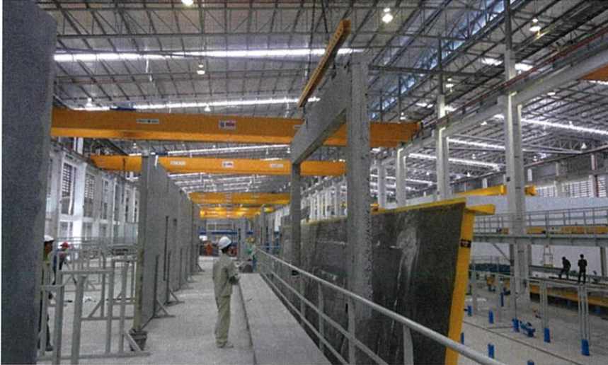
รูปที่ 2.15 การยกชิ้นงาน
