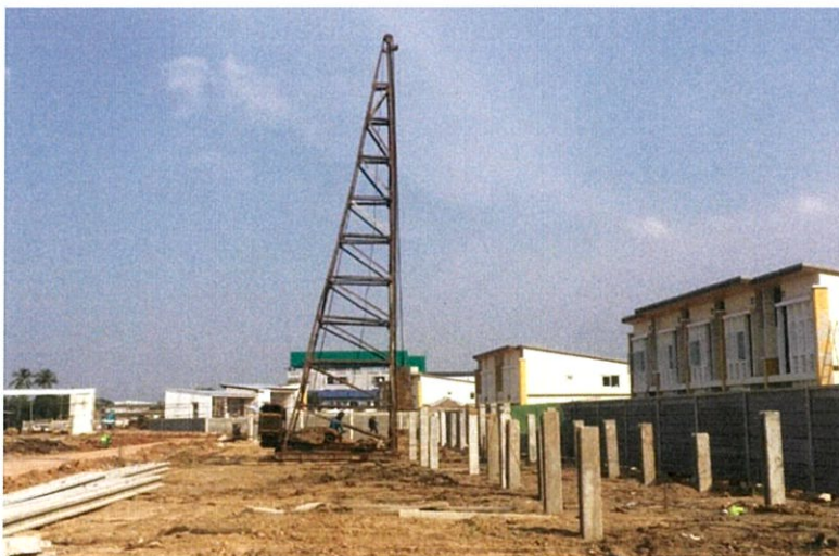
รูปที่ 3.1 การตอกเสาเข็ม
