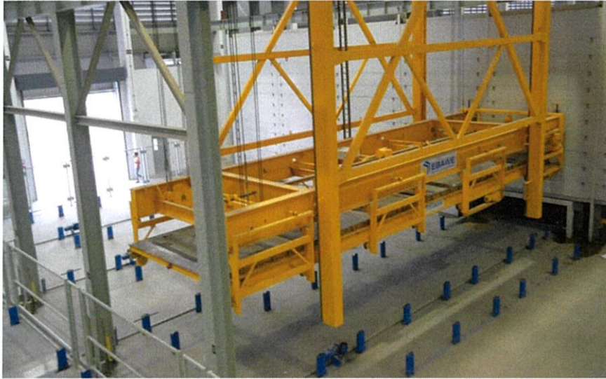
รูปที่ 2.13 การบ่มคอนกรีต
