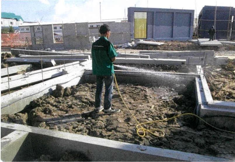
รูปที่ 3.11 กลบดินและฉีดน้ำยากันปลวก
