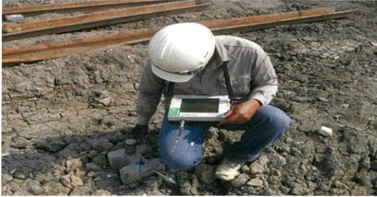
รูปที่ 3.2 การตรวจสอบเสาเข็ม
