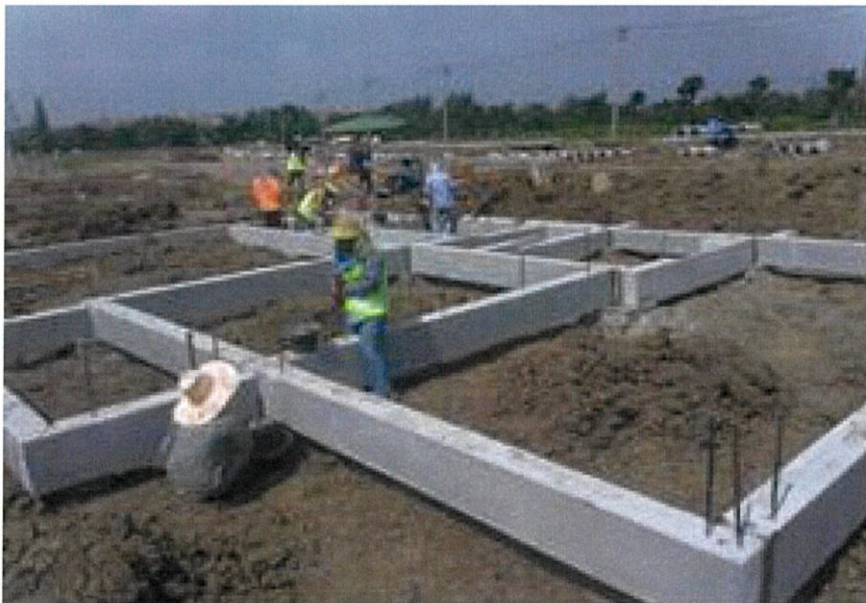
รูปที่ 3.8 งานคาน คสล.
