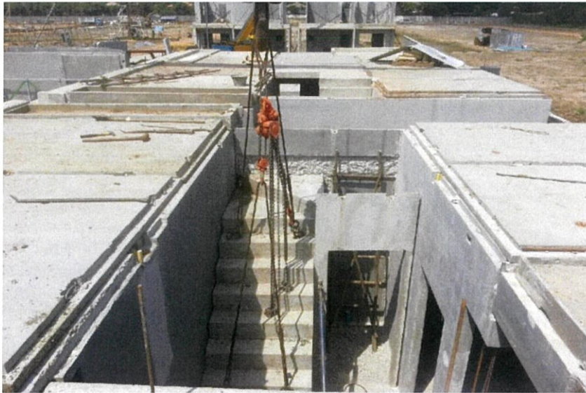
รูปที่ 3.17 การติดตั้งบันได
