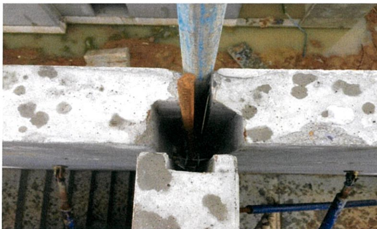
รูปที่ 3.20 ตำแหน่งการเกร้าท์ที่อคลอลูกเกตด้วยนอนซิ่งค์เกร้าท์
