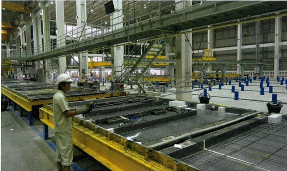
รูปที่ 2.9 วางโครงเหล็กเสริมความแข็งแรง
