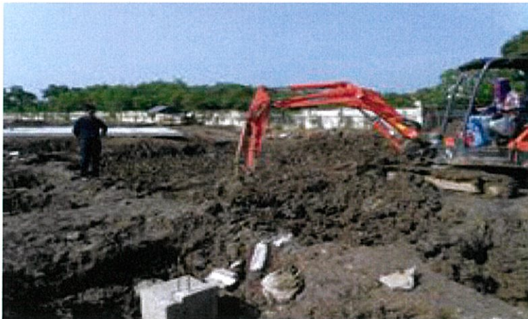
รูปที่ 3.6 การขุดเปิดหน้าดิน
