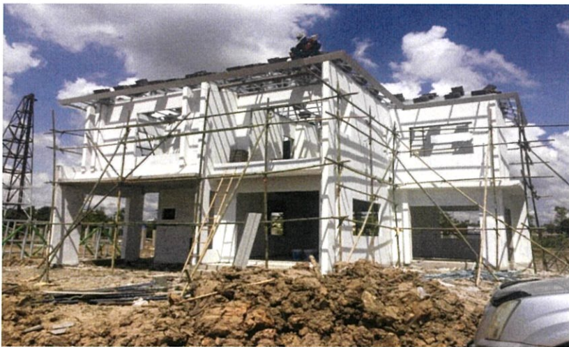
รูปที่ 2.3 การก่อสร้างบ้านด้วยผนังคอนกรีตรับแรง
