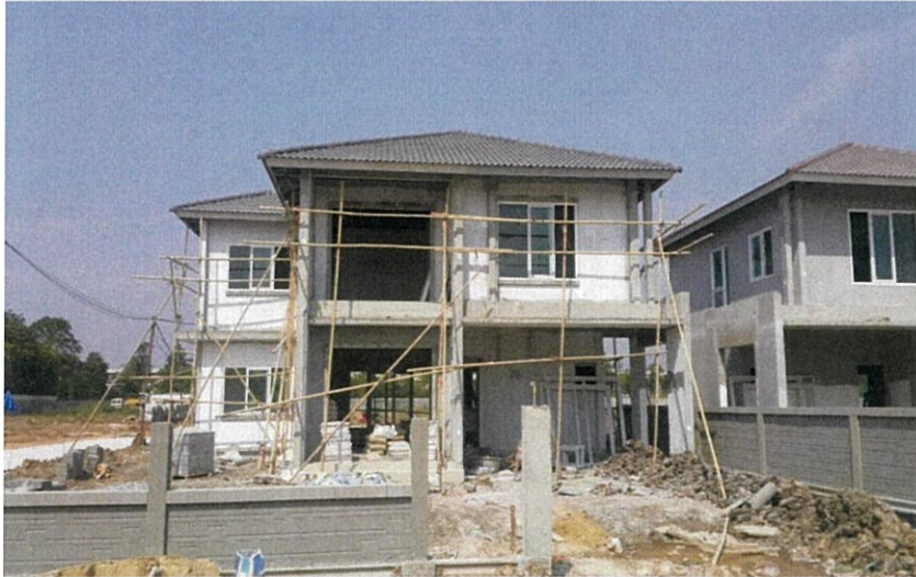
รูปที่ 3.23 งานติดตั้งกระเบื้องหลังคา
