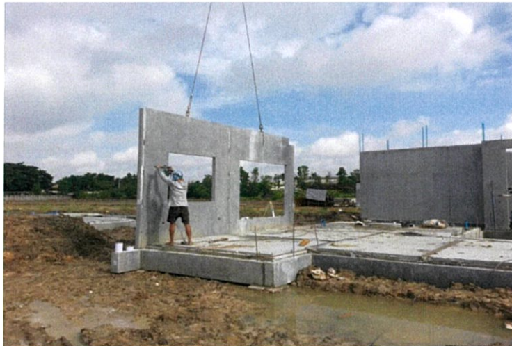
รูปที่ 3.14 ติดตั้งผนังชั้น 1
