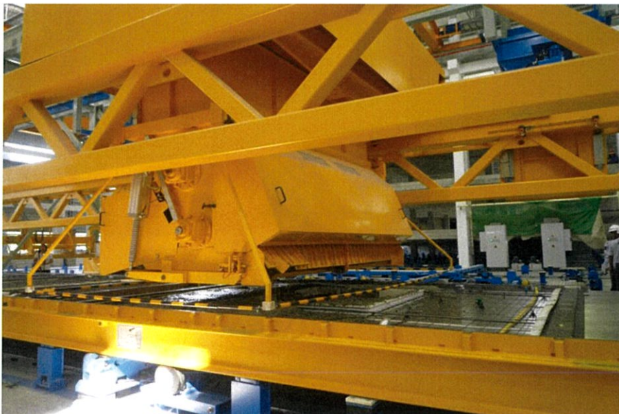
รูปที่ 2.10 การเทคอนกรีต
