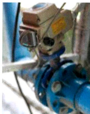
รูปที่ 5.2 วาล์วควบคุมการไหลชนิดปีกผีเสื้อ (Butterfly control valve)
