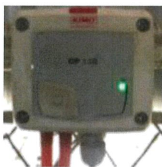
รูปที่ 5.3 Differential pressure transmitter ของอากาศสำหรับการเผาไหม้
