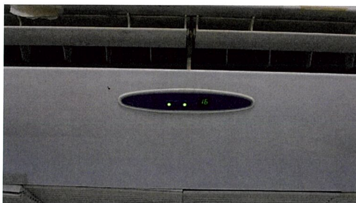
รูปที่ 4.2 ผลการทดสอบระบบควบคุมเครื่องปรับอากาศที่คำสั่ง “เปิดแอร์ 16 องศา”
