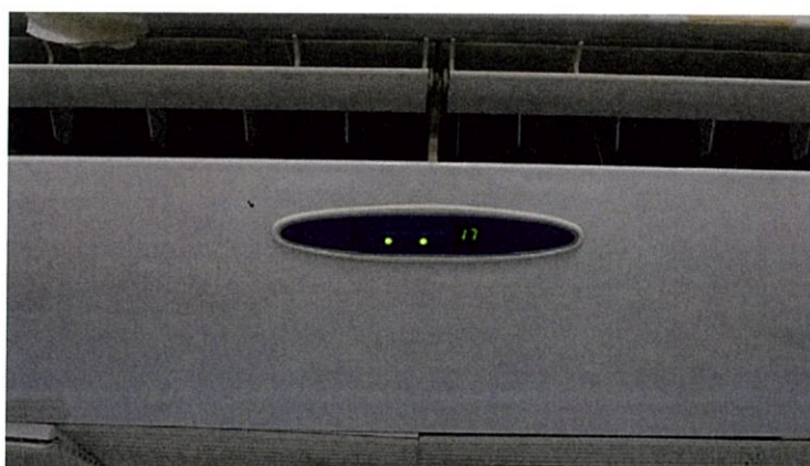
รูปที่ 4.3 ผลการทดสอบระบบควบคุมเครื่องปรับอากาศที่คำสั่ง “เปิดแอร์ 17 องศา”
