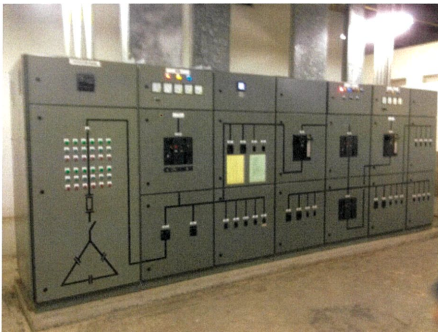
ภาพที่ 3.21 ภาพตำแหน่งที่ติดตั้ง Power Meter
