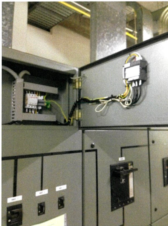
ภาพที่ 3.19 ภาพการติดตั้ง Power Meter
