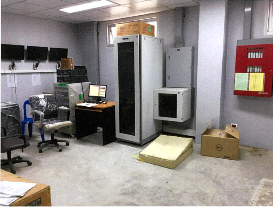
ภาพที่ 3.11 ภาพการติดตั้ง Computer Server
