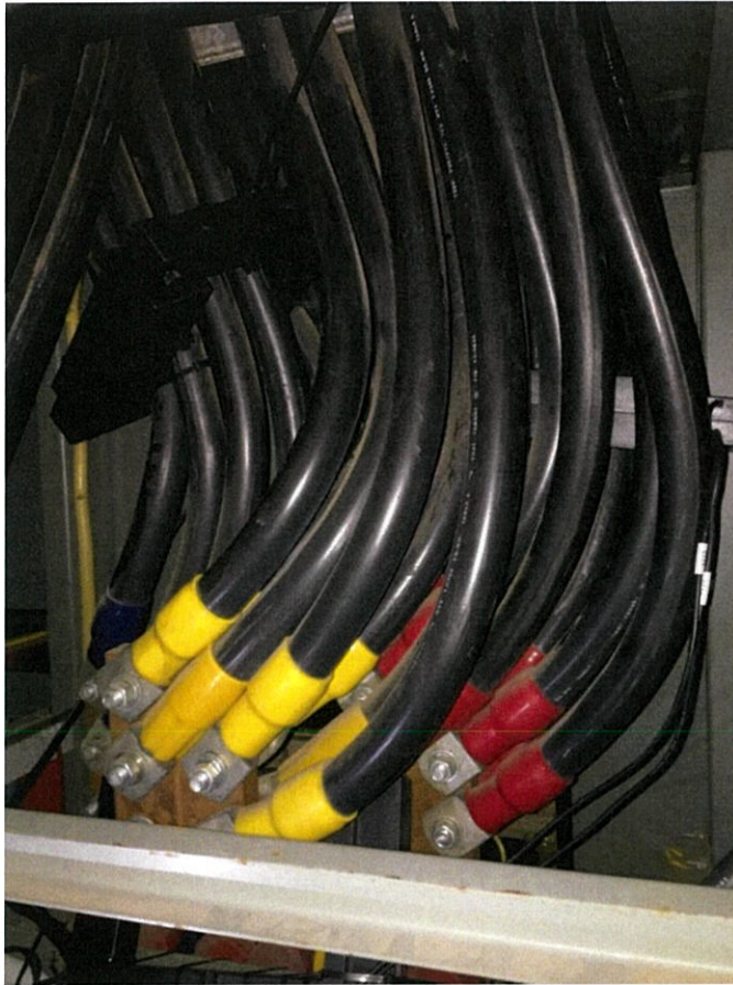
ภาพที่ 3.18 ภาพการติดตั้ง Current Transformer
