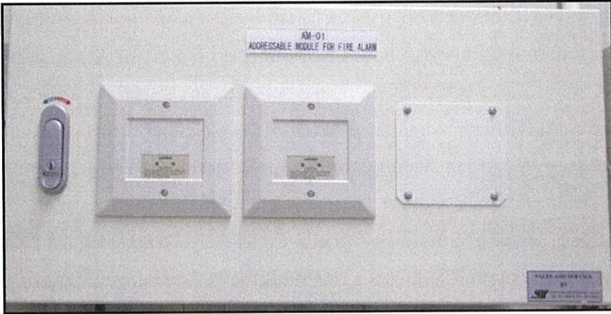
รูปที่ 3.36 ตู้ Addressable Module
