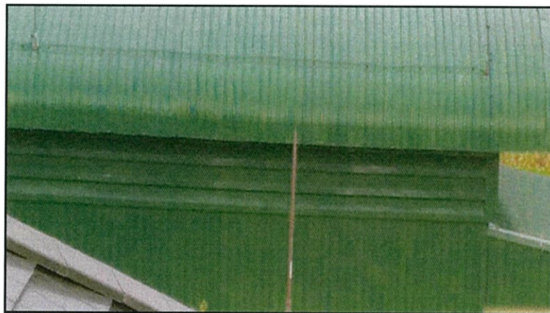
รูปที่ 3.31 ตัวนำล่อฟ้าบนหลังคา Ware House
