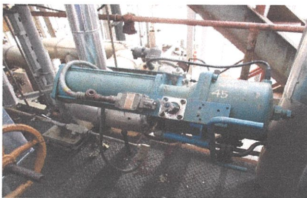
ภาพที่ 3.6 วาล์วนิรภัยของ Wasted Gas (ESV-03)
