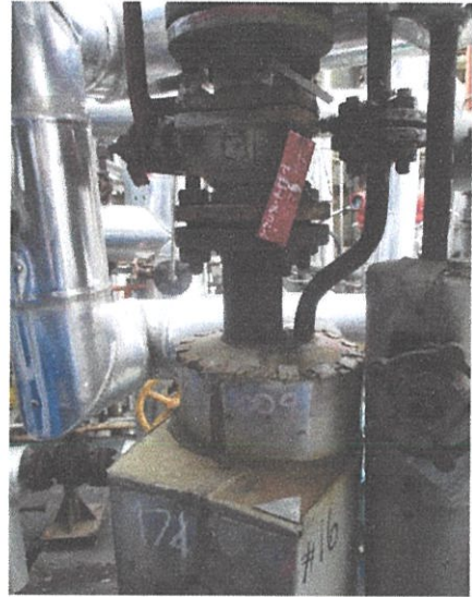
ภาพที่ 3.7 Ball Valve สำหรับควบคุมการเปิด/ปิด เชื้อเพลิงเข้าหัวเตาเผา
