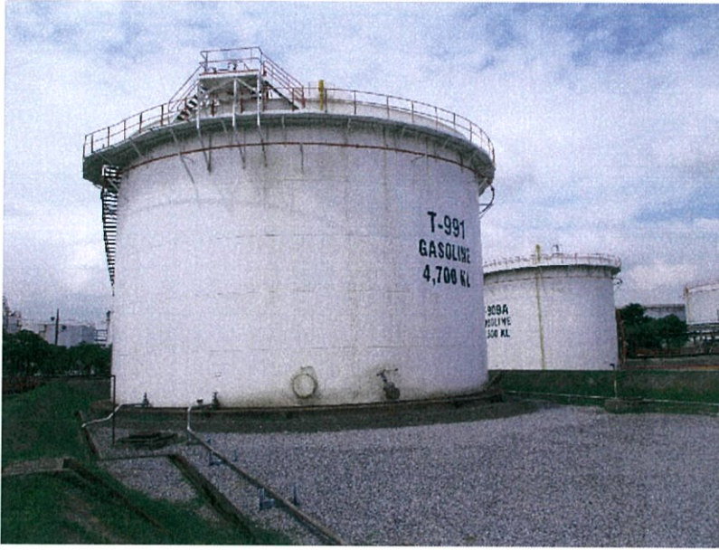
ภาพที่ 3.3 ถังเก็บน้ำมันผลิตภัณฑ์ T-991 และพื้นที่บริเวณรอบๆ ถัง (Dike)
