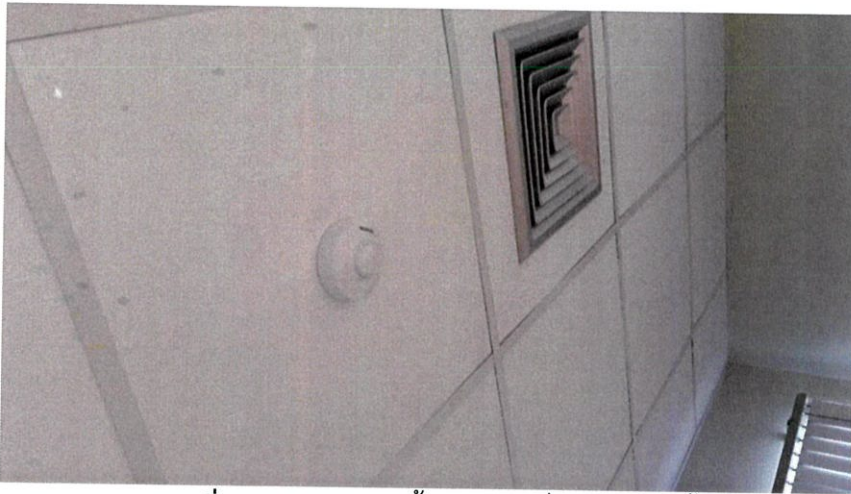
ภาพที่ 4.1 ภาพการติดตั้งเซนเซอร์ที่ห้องประชุมชั้น 1
