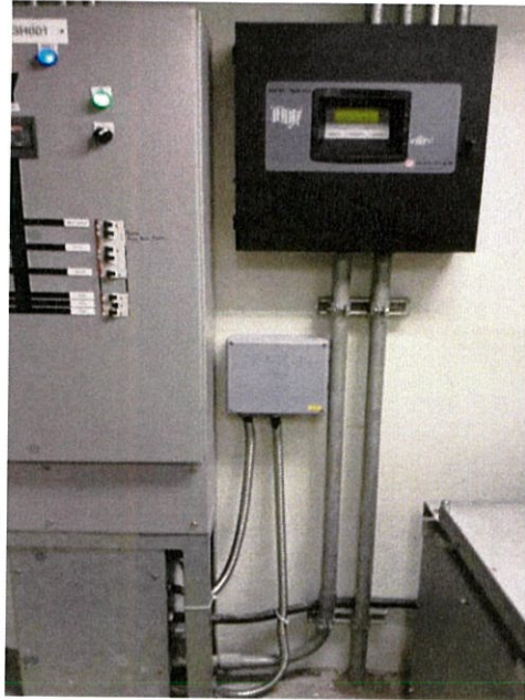
ภาพที่ 4.7 ภาพการติดตั้งชุดอุปกรณ์อาคารควบคุมไฟฟ้าของบ่อพักน้ำ
