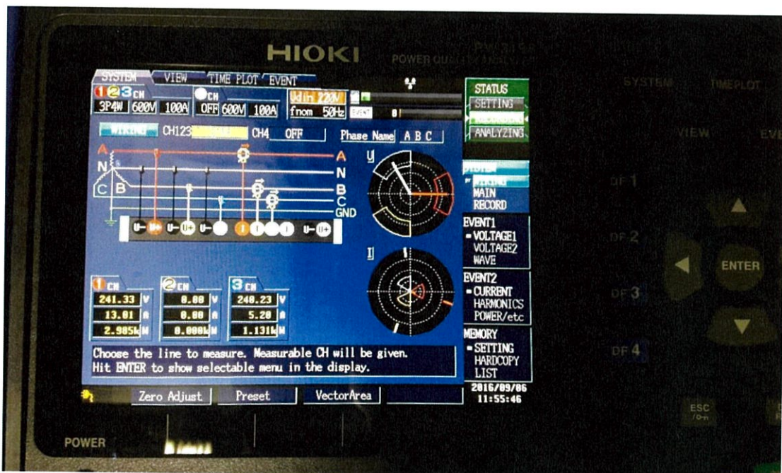
ภาพที่ ก.2 ค่ากำลังไฟฟ้าของเครื่องปรับอากาศชั้น 2
