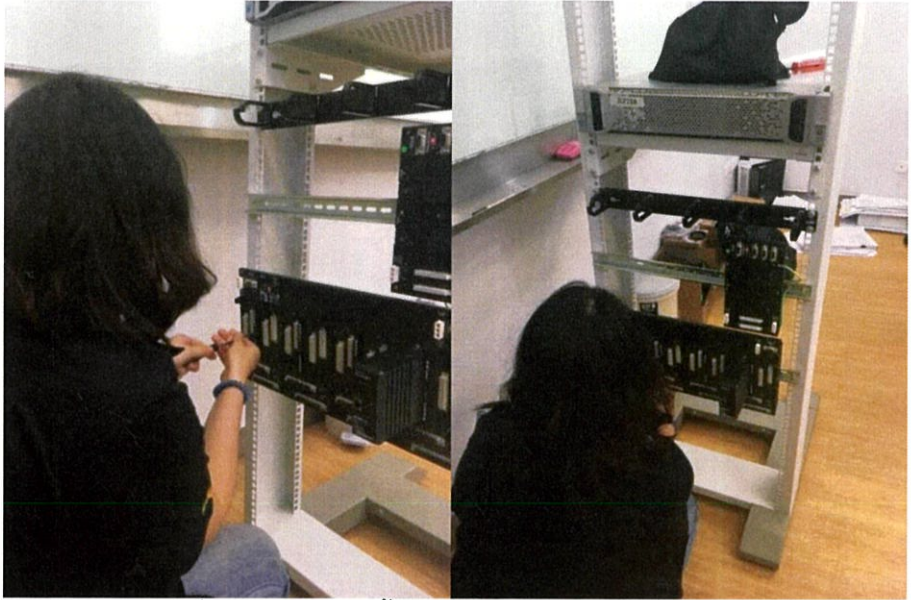
ภาพที่ 3.158 การติดตั้งอุปกรณ์เข้ากับโครง
