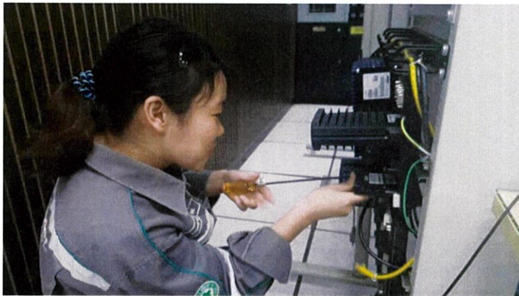
ภาพที่ 3.161 การติดตั้งอุปกรณ์เข้ากับโครง Site
