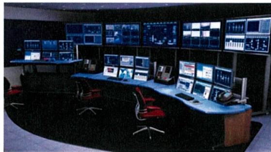
ภาพที่ 2.10 Control Room สำหรับ Operator
