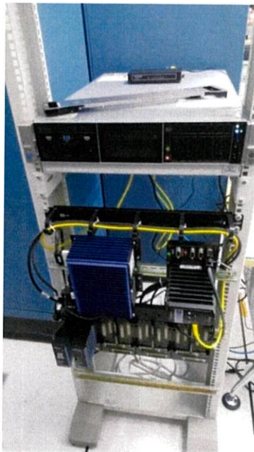
ภาพที่ 4.4 การติดตั้งฮาร์ดแวร์เข้ากับโครง
