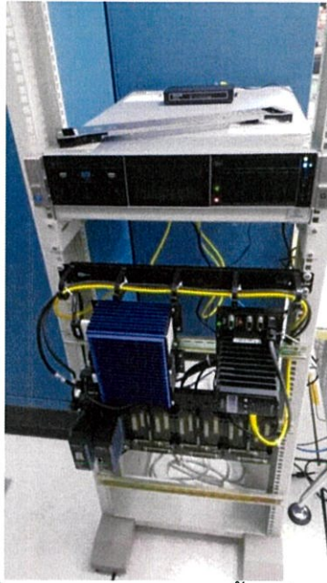
ภาพที่ 3.163 หลังทำการติดตั้งเสร็จเรียบร้อย
