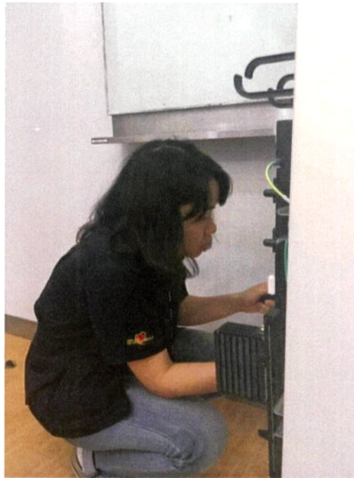
ภาพที่ 3.159 การติดตั้งอุปกรณ์เข้ากับโครง
