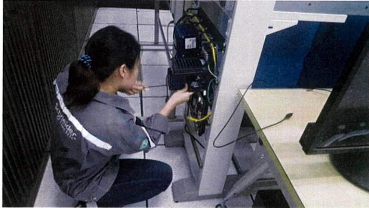
ภาพที่ 3.160 การติดตั้งอุปกรณ์เข้ากับโครงที่ Site
