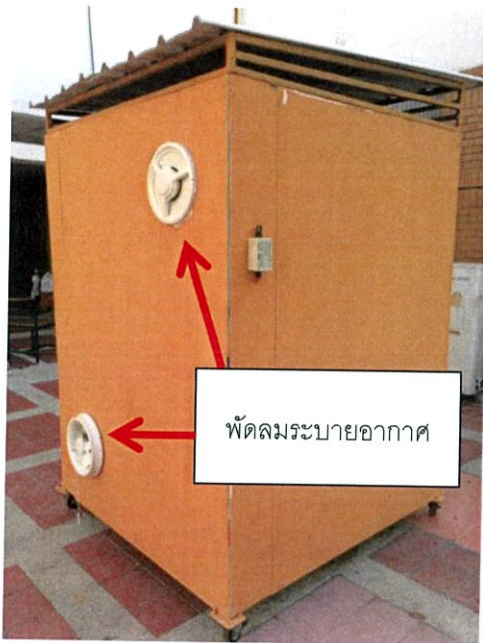
(ก) ด้านที่ติดตั้งพัดลมระบายอากาศ ที่ผนังด้านหลัง
