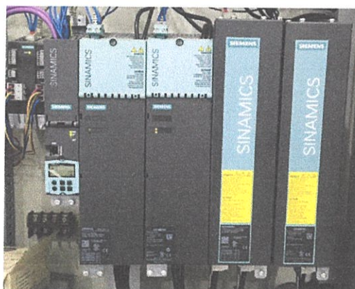
รูปที่ 3.6 อินเวอร์เตอร์ชนิด Back to back converter
