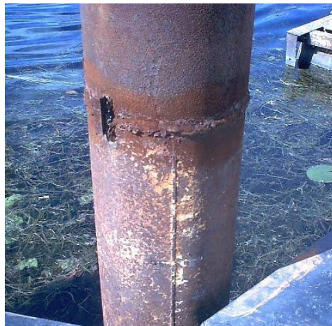
รูปที่ 2.3 ตัวอย่างชิ้นส่วนเสาเหล็กกล้าที่เกิดการกัดกร่อนแบบทั่วผิวหน้า
