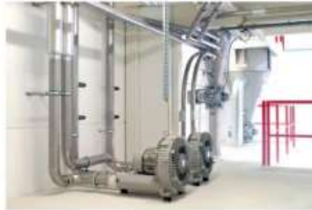
รูปที่ 2.5 ลักษณะระบบดูดฝุ่นแบบศูนย์รวม (Central vacuum system) ที่มา : Moerman and Mager (2016)
