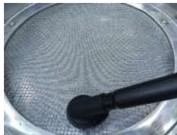
รูปที่ค.2.3 คูดฝุ่นด้วยเครื่องคูดฝุ่น ขนาด 3600 วัตต์
