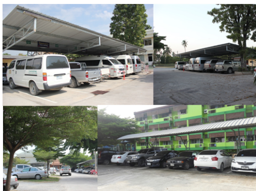
รูปที่ 4.5 ลานจอดรถ
