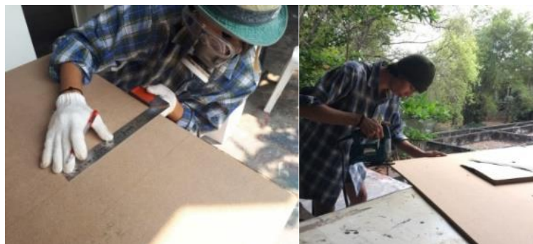
ภาพที่ 3.14 ทำการวัดและตัดด้วยเลื่อยไฟฟ้า (เลื่อยจิ๊กซอ)
