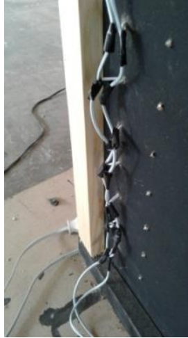
ภาพที่ 3.18 วิธีพันสายไฟกันทองแดงลัดวงจร
