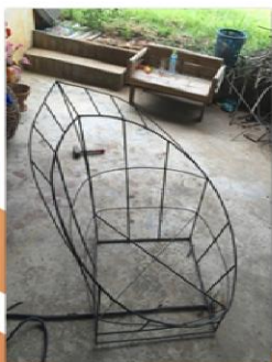
2.เสริมความแข็งแรงของโครงสร้างด้วยการตามโครงทั้ง 4 มุม
