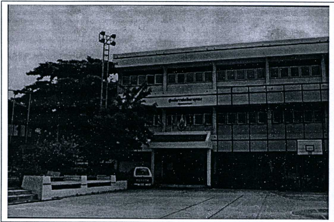
ภาพที่ 4.21 อาคารศูนย์เยาวชนวัดธาตุทอง
