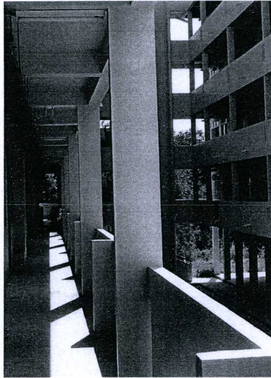
รูปที่ 4.21 รูปภาพแสดงราวกันตกระเบียง อาคารพักอาศัย 64 ครอบครั้ว
