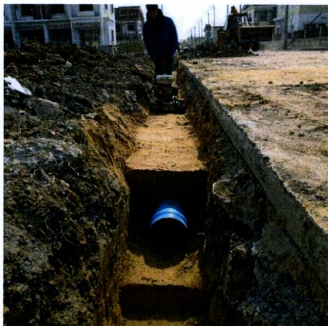
รูปที่ 2.11 การบดอัดชั้นทรายให้ได้มาตรฐานในงานวางท่อจ่ายน้ำ
