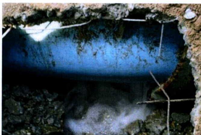
รูปที่ 2.13 การแตกรั่วของท่อจ่ายน้ำ
