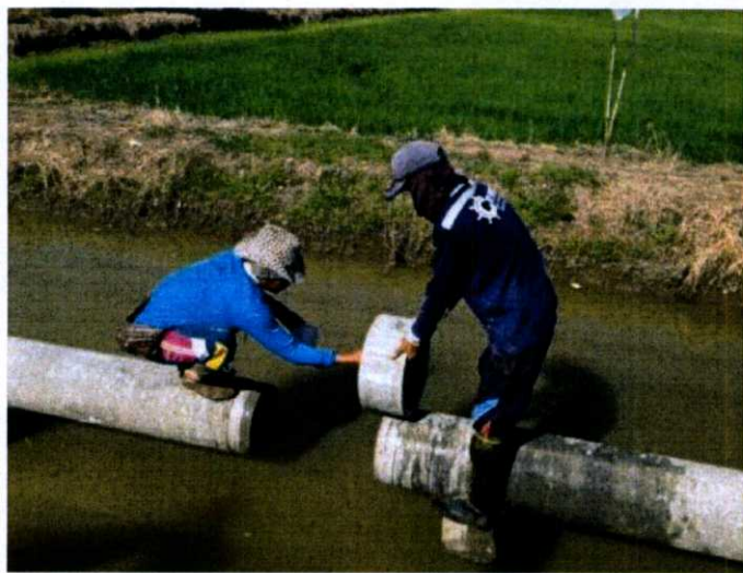
รูปที่ 2.14 การตัดบรจบท่อแยก
