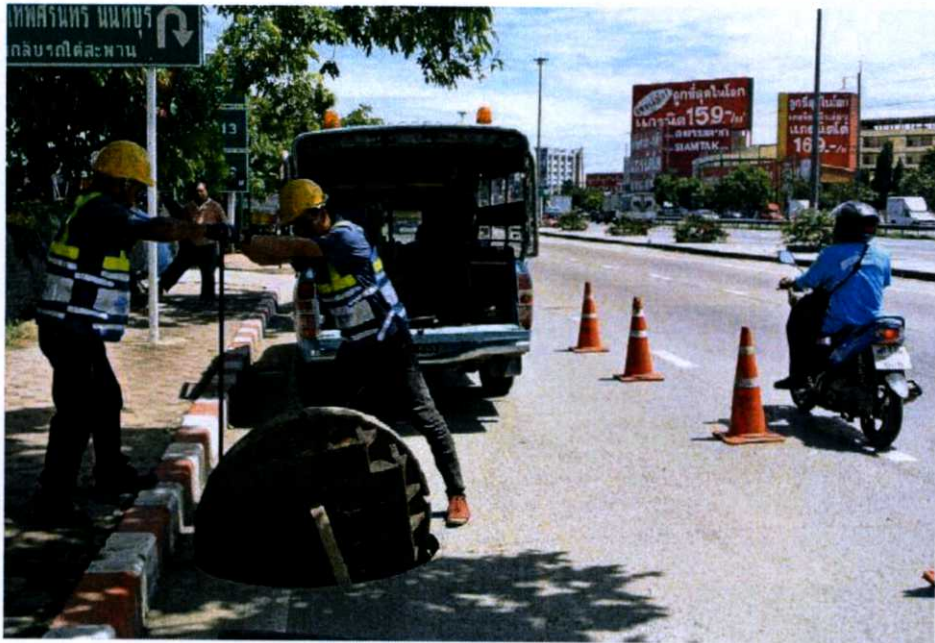
รูปที่ 2.35 การดำเนินงาน ปิด - เปิด ประตูน้ำภาคสนาม
