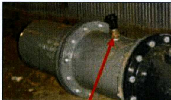
รูปที่ 2.22 Pressure Sensor และจุดวัดแรงดันน้ำบนเส้นท่อ
