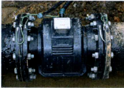
รูปที่ 2.21 Flowmeter แบบ Electromagnetic และแบบใบพัด (Turbine)
