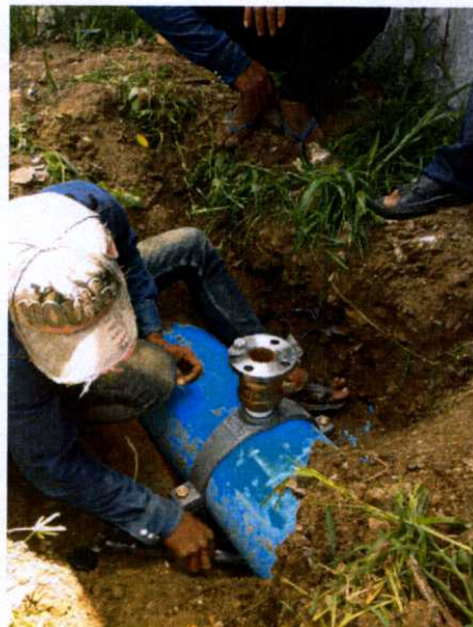
รูปที่ 4.5 การติดตั้งแคลมป์รัดท่อ เพื่อรองรับชุดอุปกรณ์
