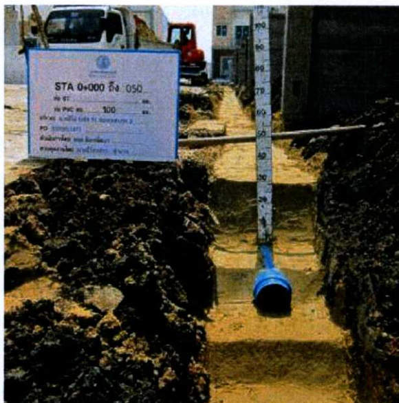
รูปที่ 2.10 การวางท่อ ชนิด PVC ขนาด ศก. 100 มม. ของการประปานครหลวง
