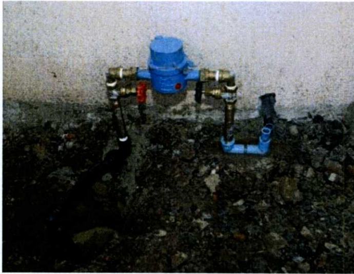
รูปที่ 2.16 การติดตั้งมิเตอร์น้ำ
