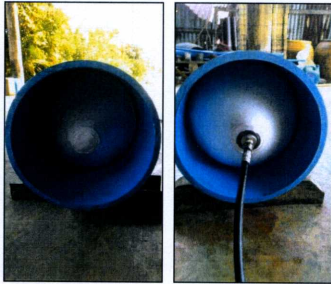
รูปที่ 4.2 การขยายตัวของปลี๊กบอลลูนและหยุดน้ำภายในเส้นท่อ
