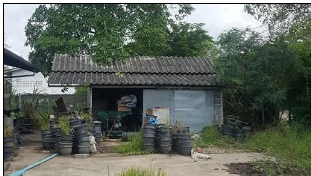
ภาพที่ 32 อาคารเก็บอุปกรณ์การเกษตรขนาดเล็ก
