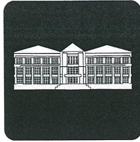
ภาพที่ 6 อาคารเรียนภาควิชา วจ.
