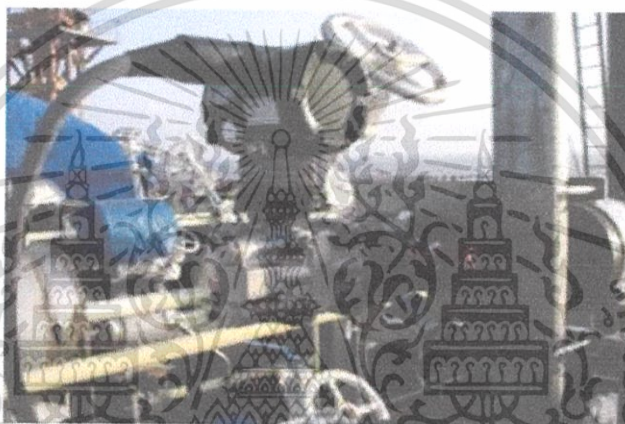
รูปที่ 2.24 การติดตั้งทรานส์มิเตอร์วัดความดันแตกต่างกับชุด Mounting Bracket
