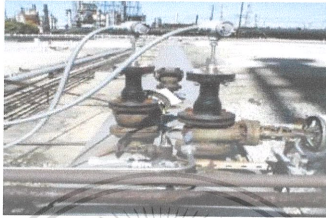
รูปที่ 2.43 ตัวอย่างการติดตั้งทรานส์ดิวเซอร์แบบ Mid Radius Bias 90
