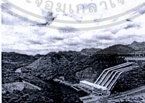
ภาพที่ 2.10 โรงไฟฟ้าพลังน้ำเขื่อนศรีนครินทร์ จังหวัดกาญจนบุรี
