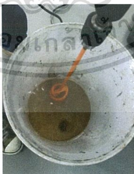
รูปที่ 3.12 แสดงการผสมส่วนประกอบ A และ B ของอิพ็อกซีเกร้าท์
