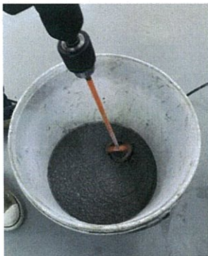
รูปที่ 3.13 แสดงการผสมส่วนประกอบ A B และ C ของอีพ็อกซีเกร้าท์
