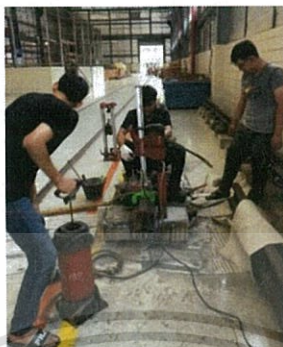
รูปที่ 3.32 แสดงการซ่อมบำรุงหมอนคอนกรีตด้วยวิธีการเจาะคว้าน
