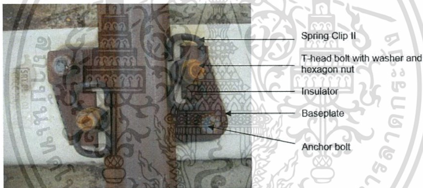
รูปที่ 2.1 Spring Clip –II Type indirect Fastening System
