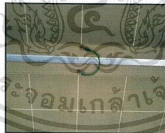
รูปที่ 3.10 สายกราวด์ที่เชื่อมระหว่างแผงขนาด 2.5 Sq.mm ผ่านช่อง Ground Hole
