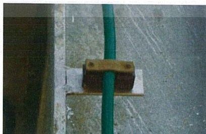
รูปที่ 3.8 แคลมป์ยึดสายกราวด์
