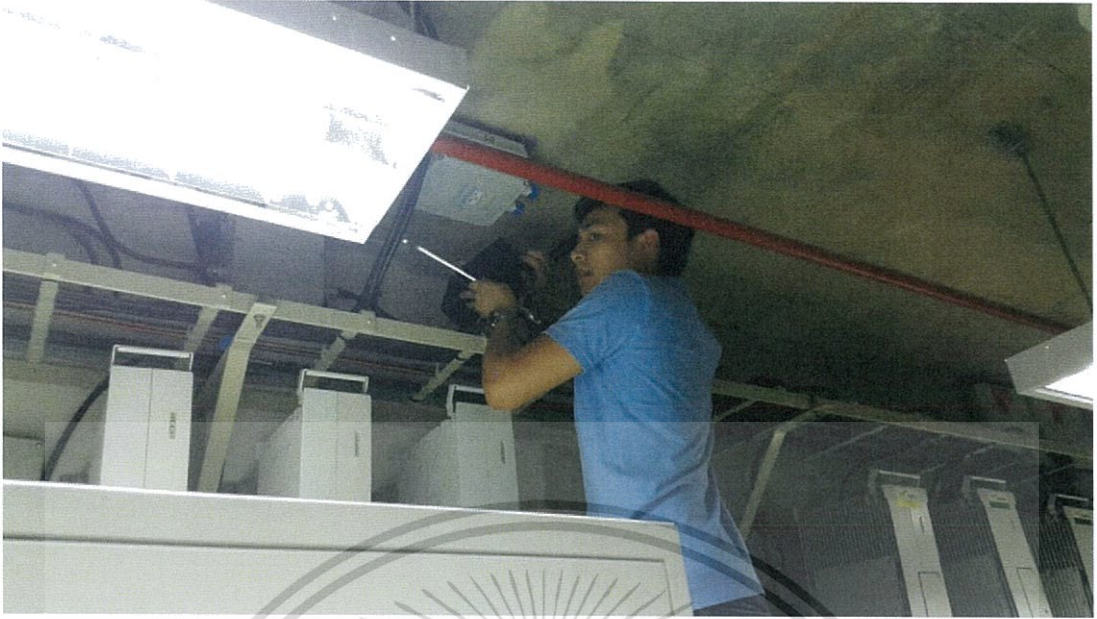
รูปที่ 3.23 ใช้ dummy load ต่อเข้ากับ RRU850
