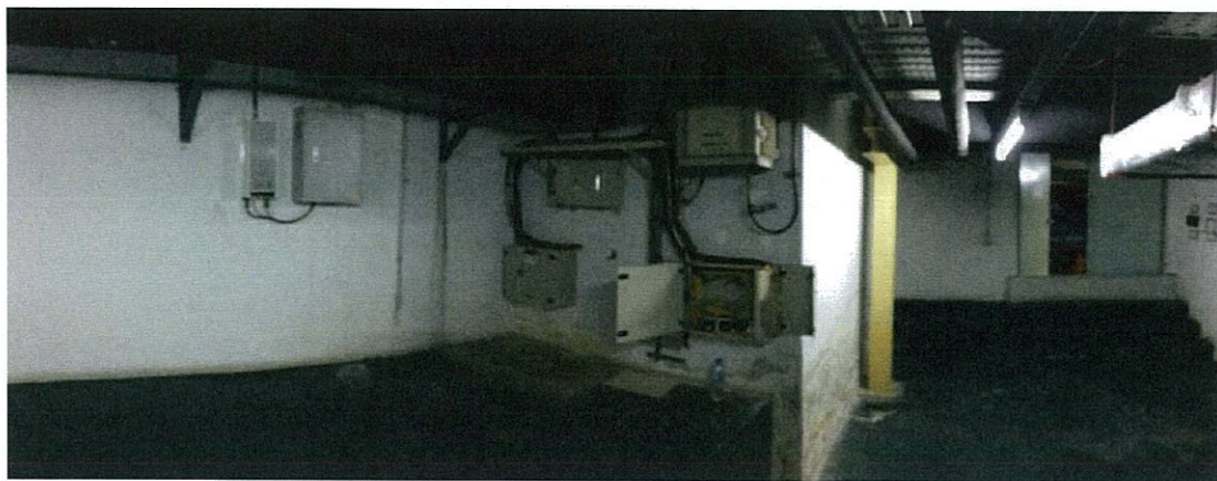
รูปที่ 4.2 พื้นที่ห้องสถานีฐาน
