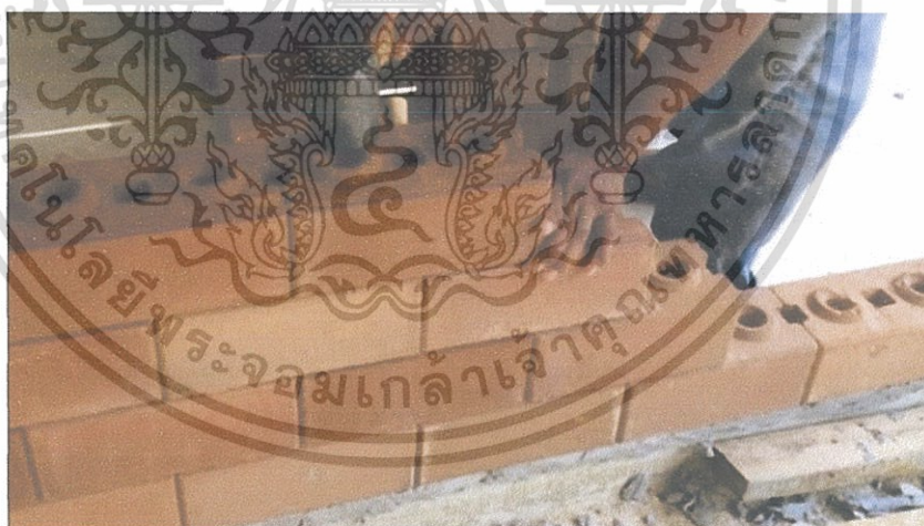
รูปที่ 2.10 แสดงลักษณะการกอบล็อกดินประสานให้ตรงแนวเชือก
