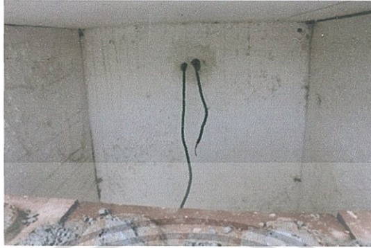
ภาพที่ 3.8 แสดงลักษณะการติดตั้ง Sensor ที่ภายในกล่องทดลอง
