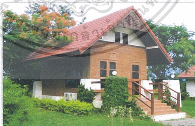
รูปที่ 2.2 แสดงลักษณะอาคารจากบล็อกดินประสาน
