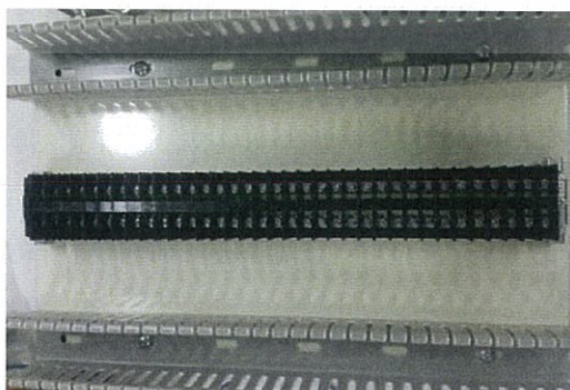
รูปที่ 3.16 ติดตั้งรางครอบสายไฟ รางรีเลย์ เทอร์นิมอลสายไฟ และอุปกรณ์อื่นๆ
