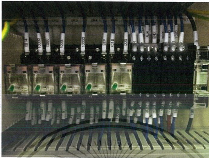
รูปที่ 3.17 ทำการ Wiring อุปกรณ์ต่างๆในบอร์ด
