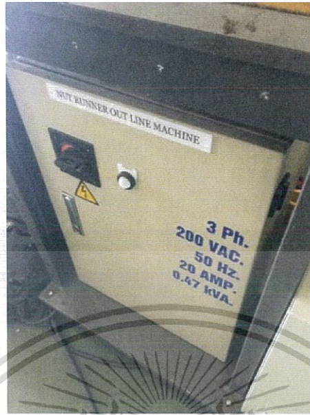
รูปที่ 4.14 ตู้ควบคุมถูกติดตั้งเข้ากับตัวเครื่องจักรพร้อมทำการ Machine Wiring
