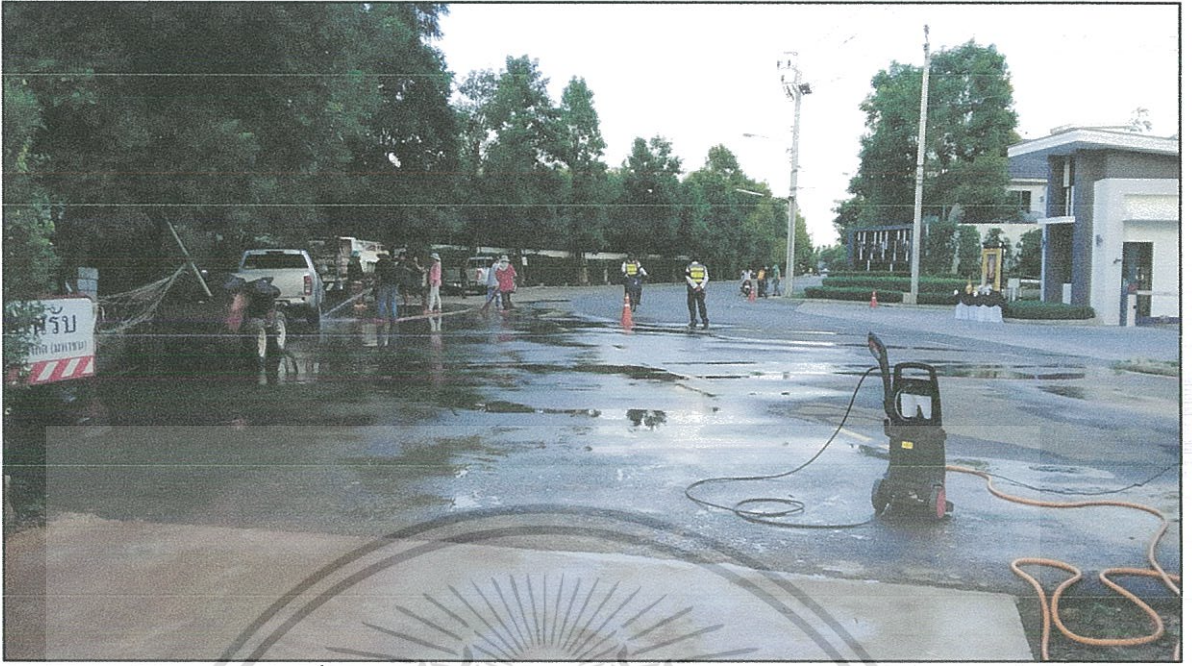
ภาพที่ 4.6 การทำความสะอาดถนนหลังจากมีการขุดดินเสร็จ
