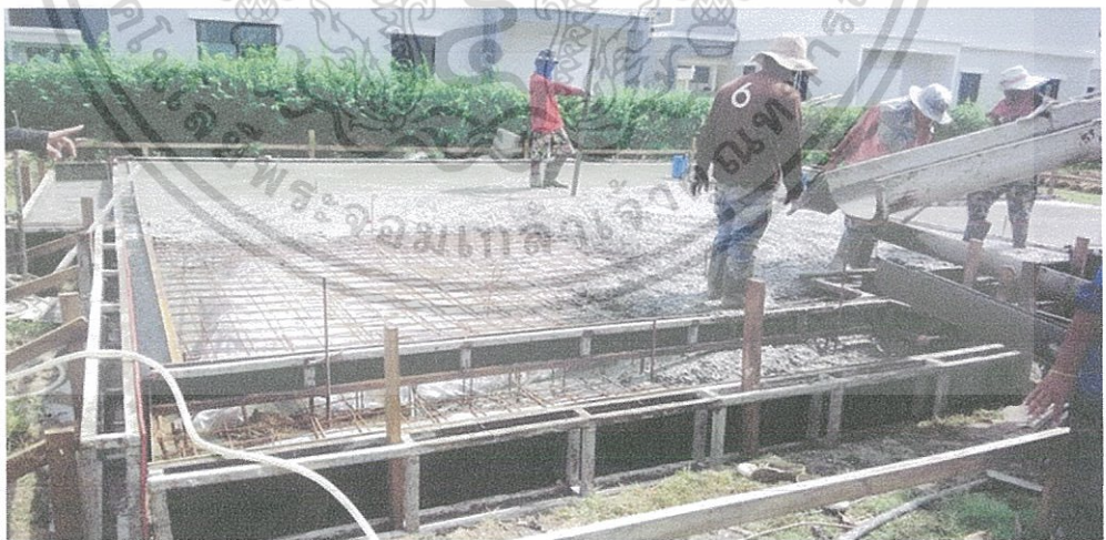
ภาพที่ 1.1 การคุมหน้างานโดยคุมการเทคอนกรีตพื้นชั้นที่ 1
