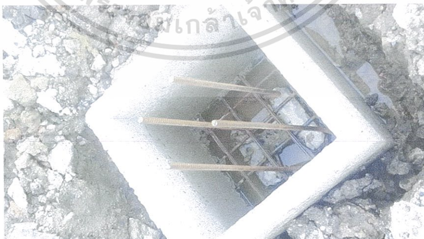
ภาพที่ 3.17 เสาเข็มและฐานราก
