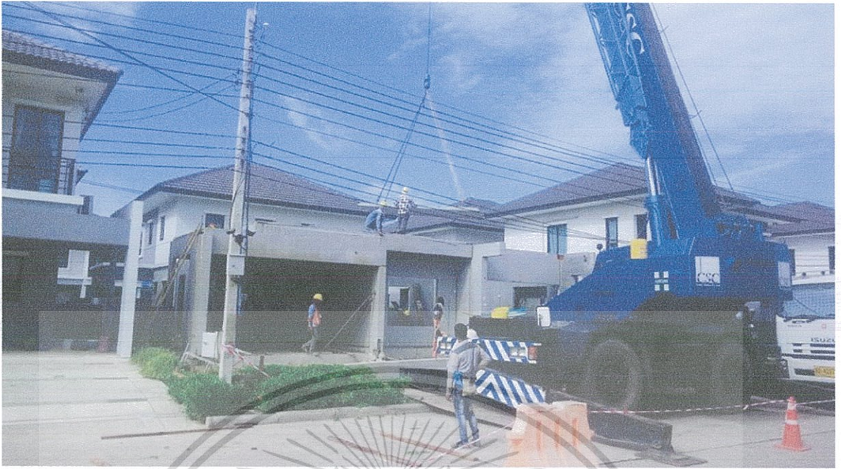
ภาพที่ 4.2 การต้งแผ่นคอนกรีตสำเร็จรูป
